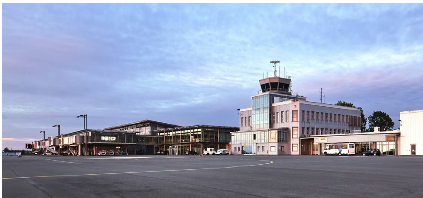
Flughafen Paderborn/Lippstadt: kritische Infrastruktur mit hohen Sicherheitsanforderungen.
