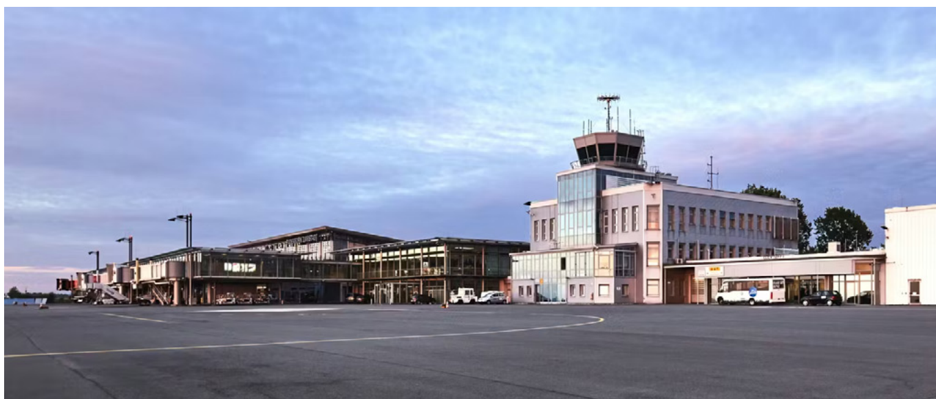
Aeropuerto de Paderborn/Lippstadt: infraestructura crítica con altas exigencias de seguridad.
